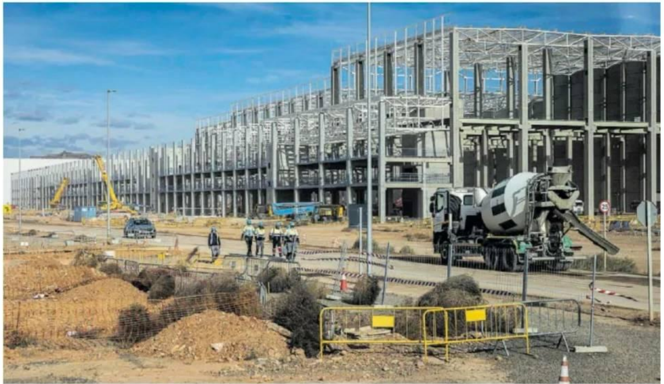
Obras de la gigafactoría de baterías de PowerCo, en Sagunto. MÓNICA TORRES
